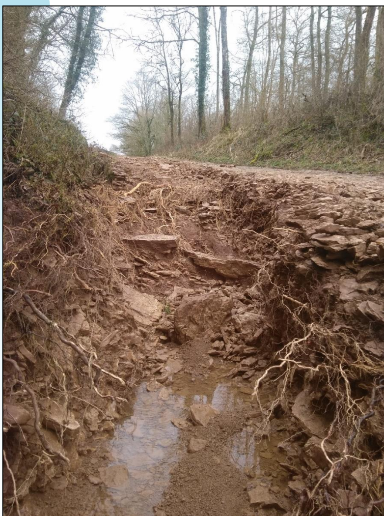
Erosion d'un chemin à Bussy-le-Grand suite à l'orage du 11 mars 2018
