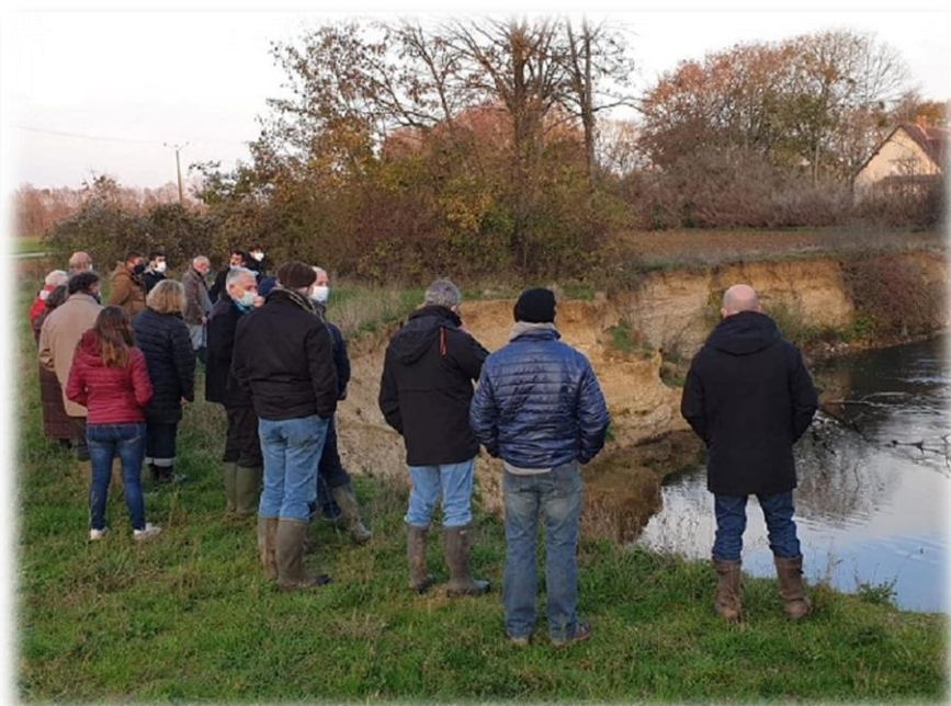
Commission Armançon aval - Erosion de Jaulges (89)
