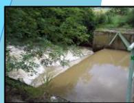
Dans les deniers grands travaux hydrauliques qui ont assaini la vallée en facilitant l'écoulement de l'eau (rectification, curage...), il a été édifié sur l'Armançe des clapets permettant de compenser le manque d'eau à l'étiage. Sans entretien, ces ouvrages sont devenus néfastes et inutiles.
