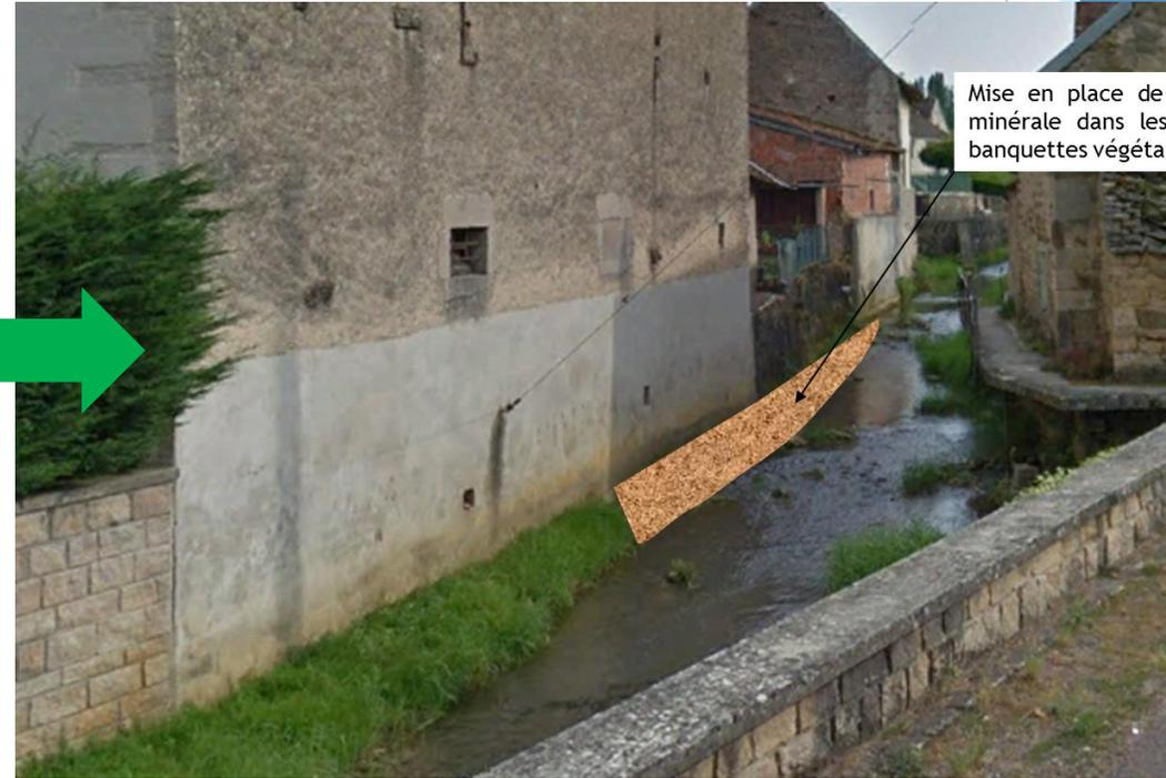
Mise en place de banquettes en technique minérale dans les zones à l'ombre où les banquettes végétalisées ne reprennent pas.
