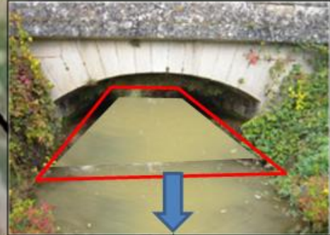
Passage sous l'ancien tracé de la D 905 : suppression du seuil en tuf.
