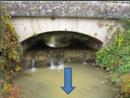
Passage sous l'ancien tracé de la D 905 colmaté par le tuf vu depuis l'aval.
