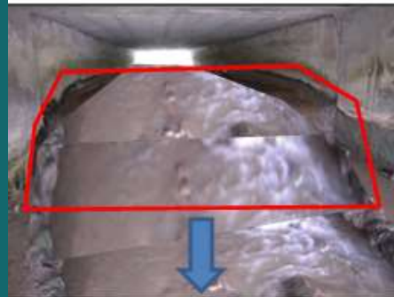
Passage sous la D 905 : suppression du seuil en tuf.
