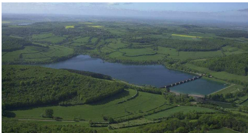
Photo 13 : vue aérienne du réservoir de Grobois (21)
