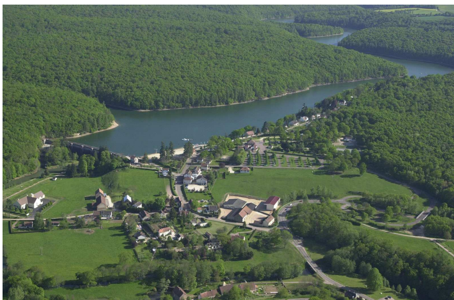
Photo 11 : vue aérienne du réservoir de Pont-et-Massène (21)
